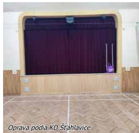
Oprava pódia KD Štáhlavice
