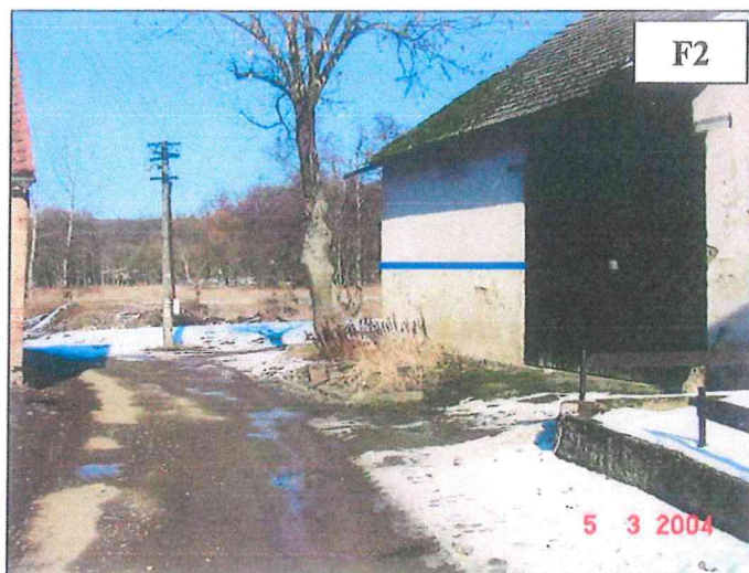
Na stodole vyznačena hladina z povodně 2002. Na konci komunikace je betonový sloup s vyznačením jednotlivých hladin povodní.
