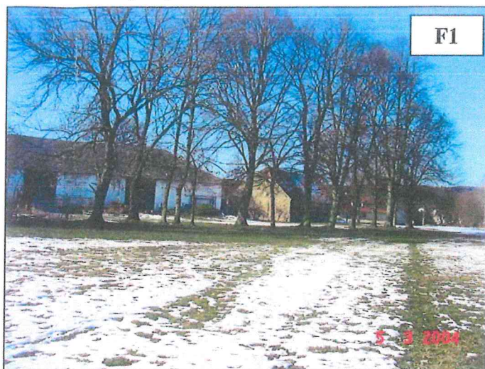
Ohrožené objekty ve Štáhlavicích - levý břeh Úslavy.
